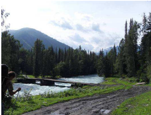
Фото №5. Мост через р. Кучерла в 300 м на юг от пос. Кучерла. Вид с левого (орогр.) берега.
