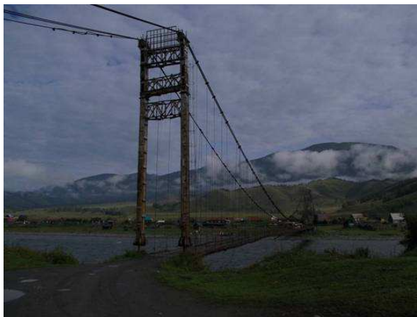
Фото №3. Мост через р. Катунь. На том берегу – пос. Тонгур и место нашей ночёвки.
