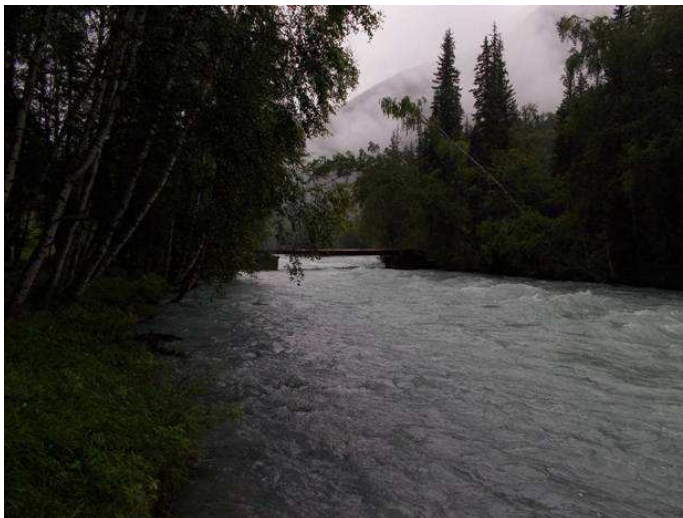
Фото №14. Мост через р. Кучерла, 1 км выше по течению от устья р. Тикоюк. Вид с севера.
